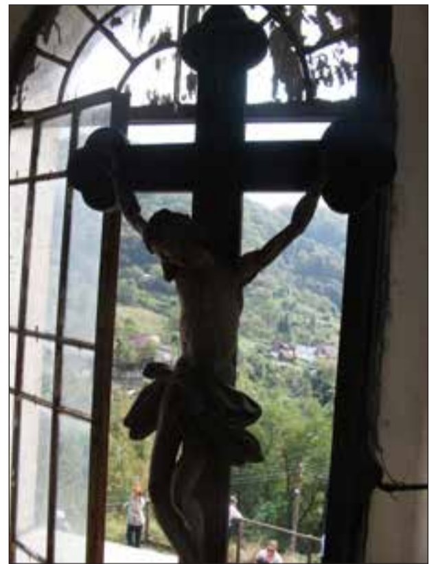
A javítás alatt álló nagyági római katolikus templom ablaka
